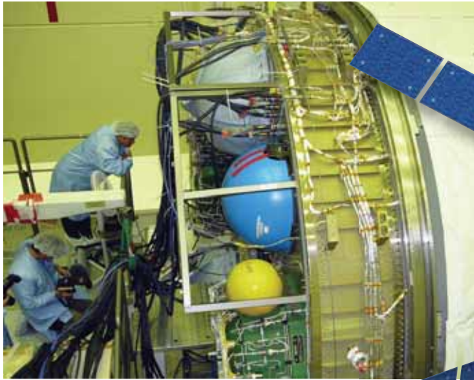
Bedrading en elektrische onderdelen van het voortstuwingsgedeelte van de Jules Verne. © Benny Audenaert
