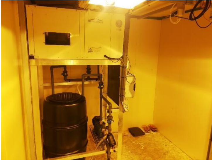
Fig. 2.3. OptiClimate™ PRO3 watergekoelde airconditioner in de teeltruimte (container) voor regeling van de luchttemperatuur en de CO 2 -concentraties.
