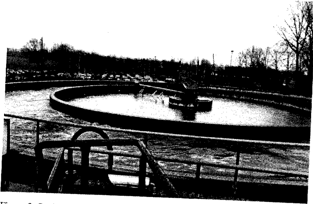
Figure 3: Station d'épuration des eaux usées de l'hôpital Erasme à Bruxelles (Débit journalier moyen: 700 m 3 ). Boues activées.
