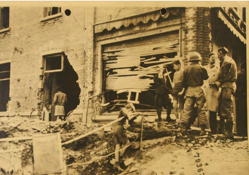
Dégâts à une maison de commerce située à la rue du Pont à La Roche-en-Ardenne, au cours de l'offensive Von Rundstedt en décembre 1944. Archives générales du Royaume 2-dépôt Joseph Cuvelier (Ministère de la Reconstruction, Archives de l'Administration des Dommages de Guerre aux biens privés, Série provinciale, Province de Luxembourg). © AGR
