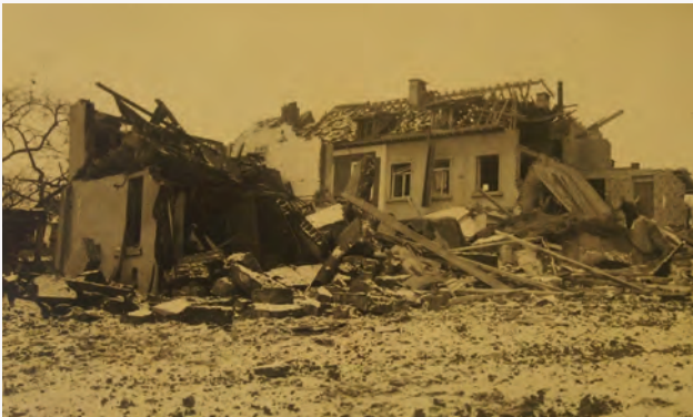
Maison détruite à l'avenue Gevaert à Genval suite à un bombardement le 26 janvier 1945. Archives générales du Royaume 2-dépôt Joseph Cuvelier (Ministère de la Reconstruction, Archives de l'Administration des Dommages de Guerre aux biens privés, Série provinciale, Province de Brabant). © AGR
