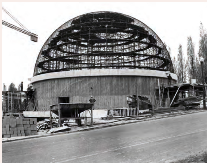
Construction du nouveau Planétarium en 1974.
