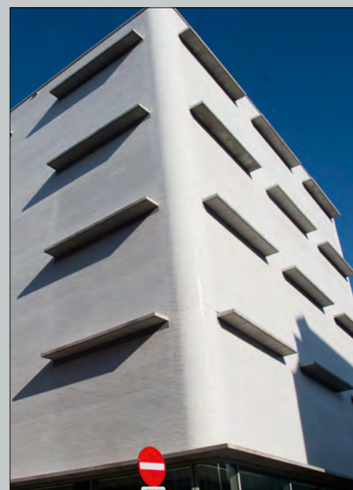
La majorité des espaces de stockage des archives se trouve au sous-sol du nouveau bâtiment des Archives de l'État. © AGR
