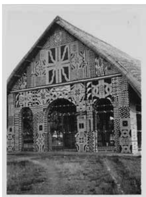
Henri Goldstein (°1920). Het gerechtsgebouw van Niangara . Niangara, Haut-Uele, DRC [Bangba], 1949. EP.0.0.468, collectie KMMA Tervuren, (Inforcongo), © KMMA Tervuren
