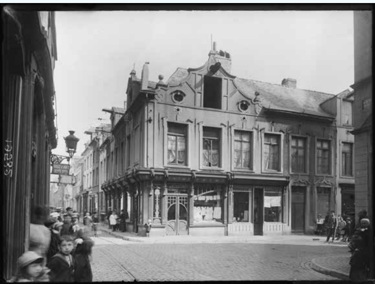
Fig. 5 : Maison dans la Half-Maartstraat à Louvain. Deux militaires allemands contiennent la foule pour dégager le champ devant cet immeuble du début du XVIII e siècle récemment pourvu d'une vitrine Art nouveau. Les regards des spectateurs, y compris ceux de bambins à l'intérieur du bâtiment, convergent vers le photographe. Les Allemands ont visiblement demandé à un garçonnet de garder la pose en s'accoudant au bâtiment, sans doute pour donner une échelle de proportions. © KIK-IRPA, Bruxelles, 1917-1918, B019582.
