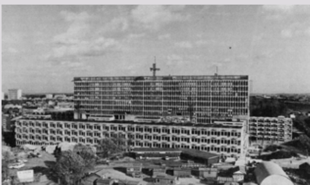
Construction de la Cité Reyers en 1970, dans : RTB, Le point d'interrogation , fév. 1971, p.2.
