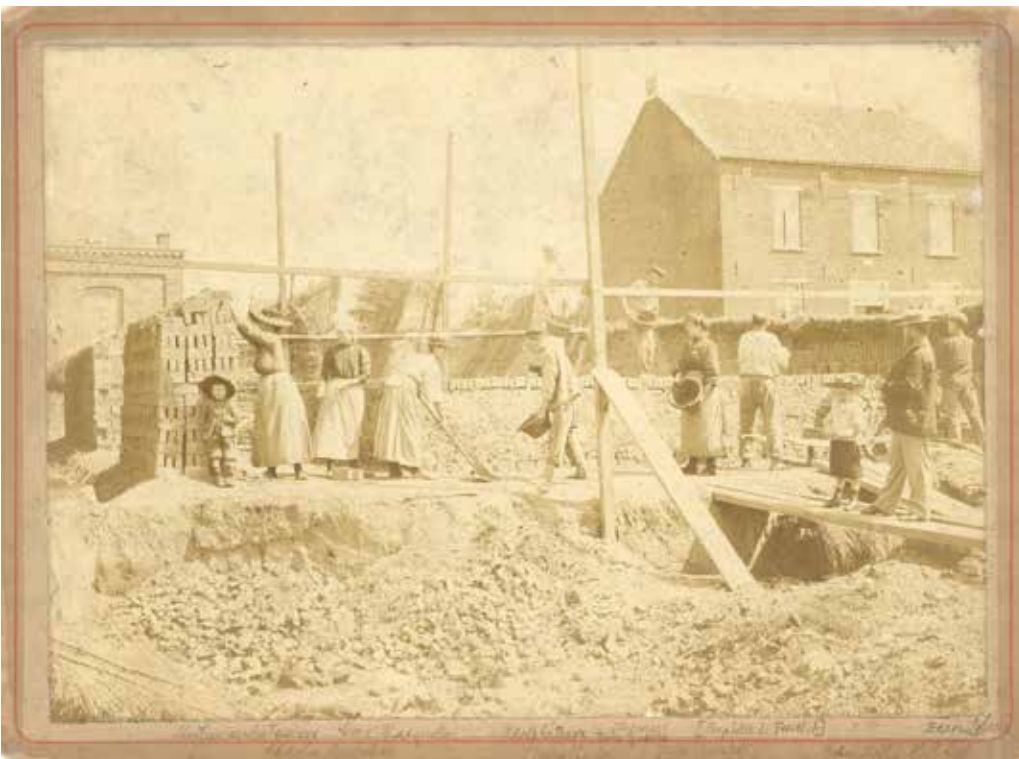
Aanmaak van stenen voor de bouw van een turnzaal bij de tempel, 1899 (Protestantse Kerk van Courcelles). © L. Druetz
