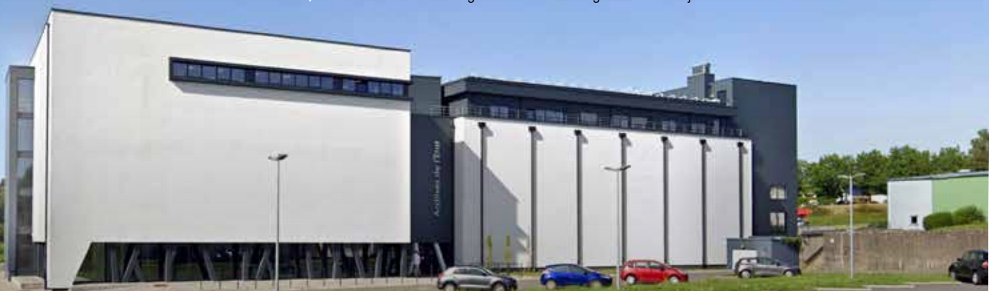
De hoofdfaçade van het gerenoveerde en uitgebreide gebouw van het Rijksarchief te Aarlen.
