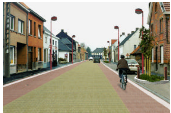
Een doortocht van een bebouwde kom. Het principe van gemengd verkeer is hier toegepast: fietssuggestiestroken, geen
